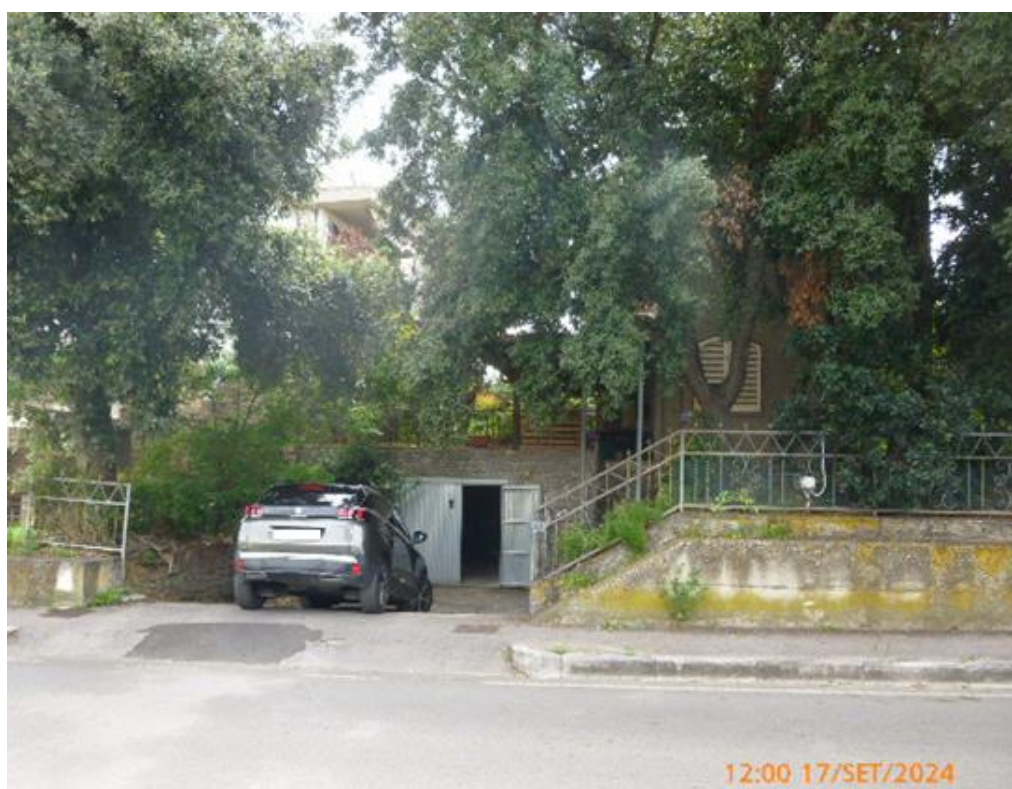
Accesso lato facciata principale
